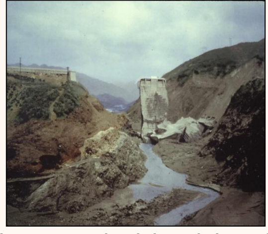
Jeolojik yapı nedeniyle yıkılmış bir baraj (St. Francis Barajı, ABD) (web.mst.edu)
