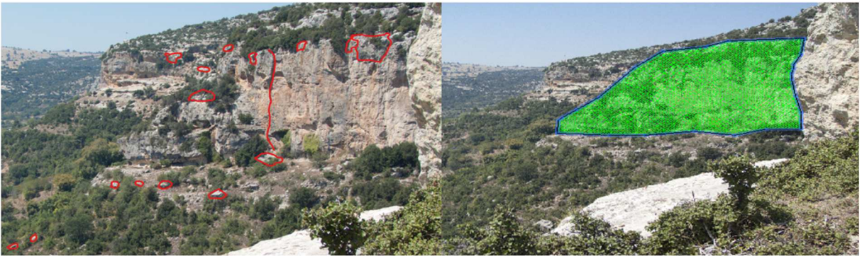
Şekil 8. İkinci bölge için tasarlanan çelik tel ağ ve güçlendirilmiş çelik tel ağ.
