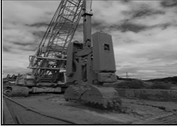
Şekil 7. Grab tip Slurry Trench mak. (www.istasazeh.com).
