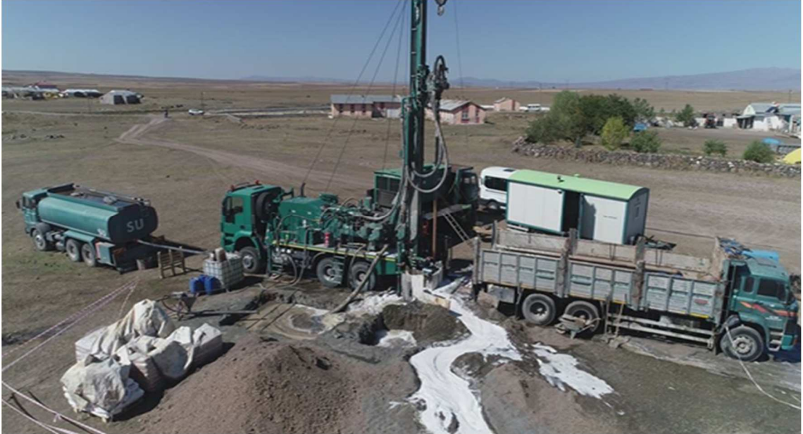
Şekil 10. Su sondaj şantiyesi.
