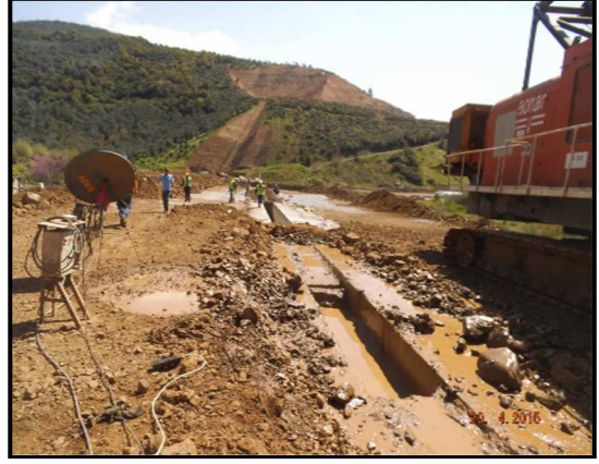
Şekil 8. Slurry Trench hendeği (Çakır, 2019).
