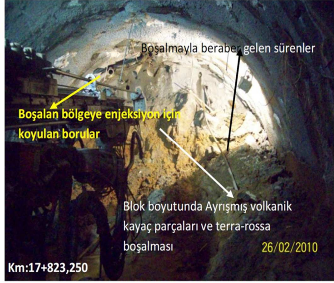
Şekil 5. Zemin boşalmasının etkili olduğu ilk 20 metre ve enjeksiyon çalışması.
