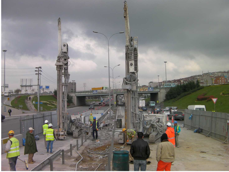
Şekil 8. Km:17+817,25 ila Km: 17+895,00 arası yüzeyden enjeksiyon yapılması için D100 karayolunun bir şeridinin kapatılması.
