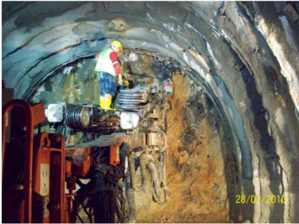
Şekil 3. Karstik boşluğun tünel eksenini boyunca yayılımını belirlemek için yapılan yatay araştırma delgileri.
