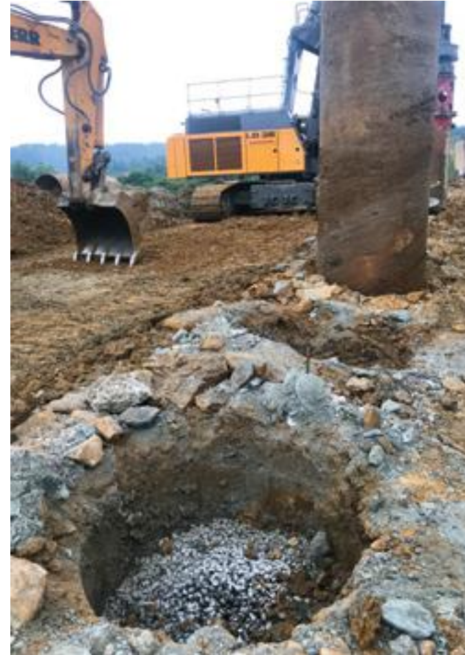
Şekil 6. Drenaj kolonu uygulamasından görüntüler.
