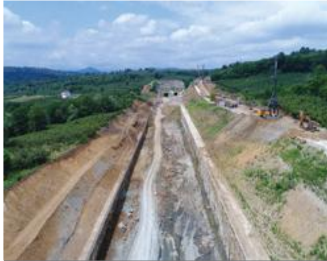
Şekil 5. Ordu Çevre Yolu heyelan bölgesinde kazıklı istinat yapılarının (yolun her iki yanında) ve yeraltısuyu drenaj kolonlarının (fotoğrafın sağında) uygulama hatlarını gösteren bir görüntü
