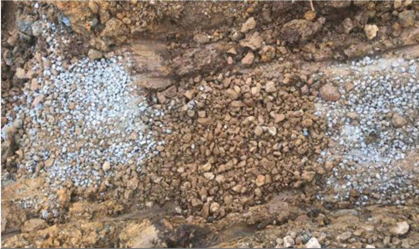
Şekil 7. Derin drenaj kolonu uygulaması (a) Poröz (gözenekli) betonu ile ve (b) kırmataş malzeme ile yapılan drenaj kolonlarının üstten görünümü
