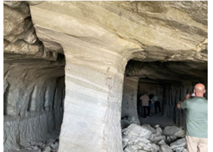
Kaya oyma mekan (At Ahır) içerisinde meydana gelen kaya kütle yenilmesi
