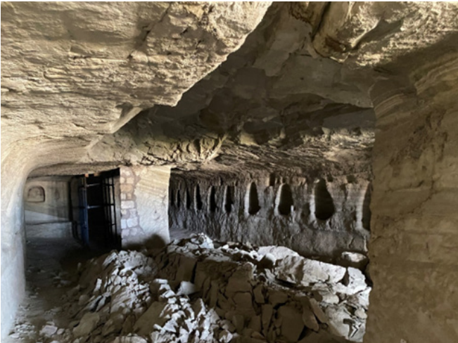
Kaya oyma mekan (At Ahır) içerisinde meydana gelen kaya kütle yenilmesi
