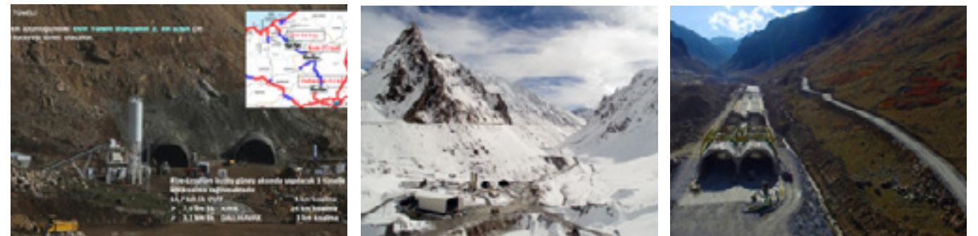
Şekil 5. Ovit Tüneli inşaatından görüntüler.
