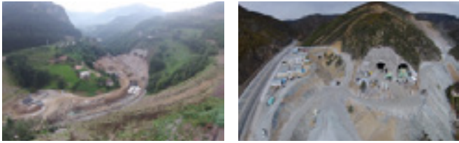
Şekil 7. Zigana Tüneli inşaatından görüntüler.
