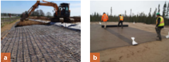
Şekil 6. (a) Tek yönlü yer ızgarası ile donatılı duvar yapımı (Fotoğraf: geosynthetica.net), (b) inşası tamamlanmış bir donatılı duvar görüntüsü (Fotoğraf: magnumstone-positive).
