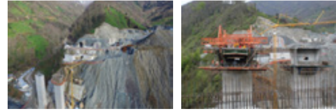
Şekil 4. Cankurtaran Tüneli (Hopa, Artvin) viyadük inşaatından görüntüler.
