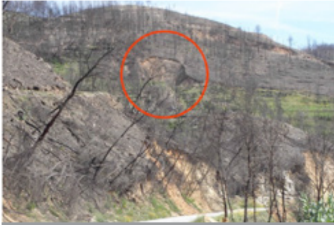
Şekil 5. São Gião, Portekiz'deki yangının ardından yol üstündeki sığ ve tepedeki derin kaymalar (Fotoğraf: Araújo Santos vd., 2020)
