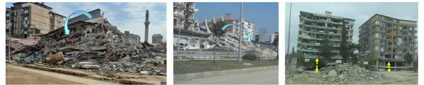
Şekil 13. Deprem bölgesinden yumuşak kat olgusu nedeniyle toptan göçen veya hasara uğramış binalardan görüntüler (Ulusay vd., 2023)
