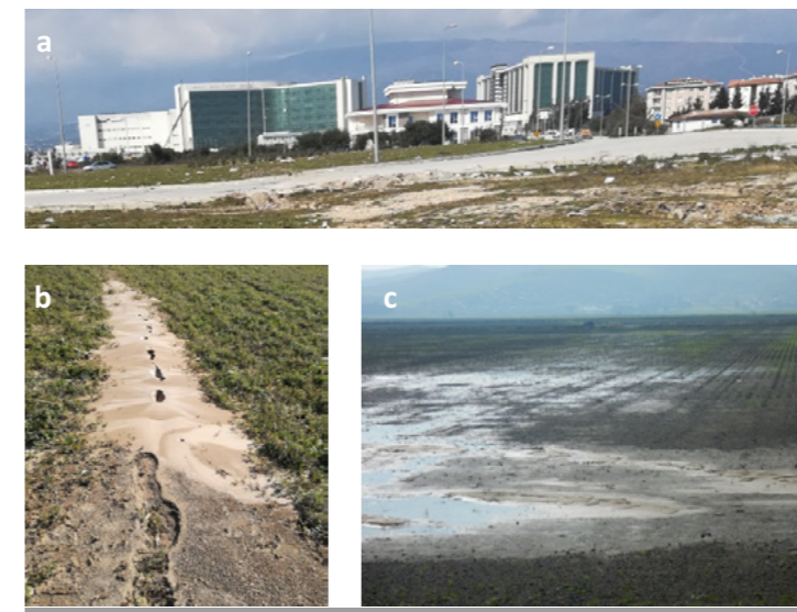
Şekil 6 (a-c) Hatay Eğitim ve Araştırma Hastanesi ile Alaatin Mahallesi arasındaki tarlalarda gözlenen sıvılaşma yarıkları ve tarlalarda su baskınları
