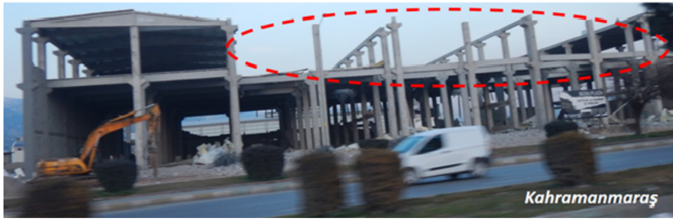
Şekil 14. Hasarlı ve göçmüş pre-fabrik betonarme çerçeveli yapılardan bazı görüntüler (Ulusay vd., 2023)
