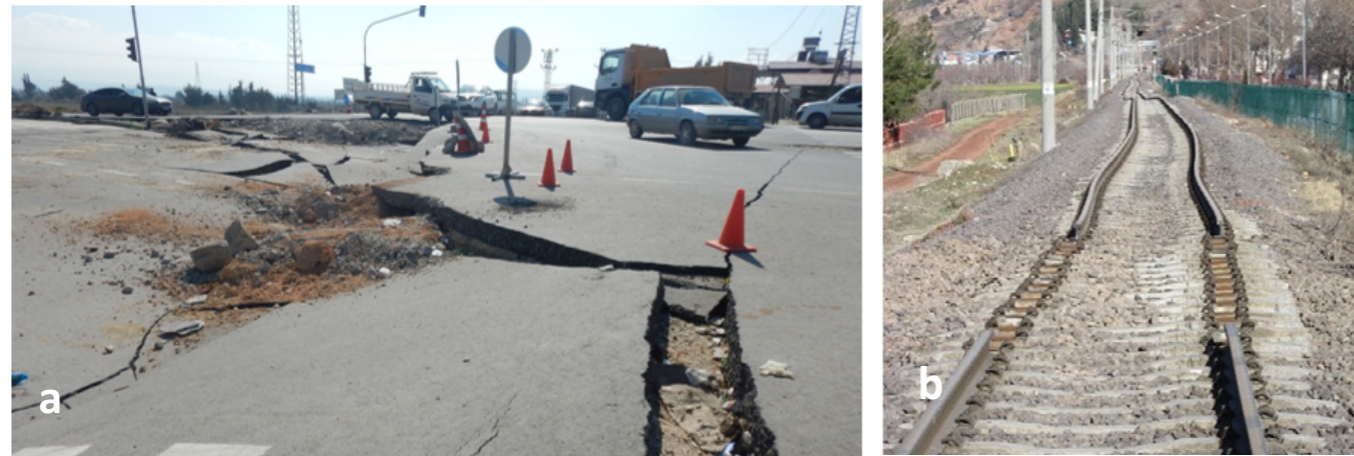
Şekil 15. Yazarlar tarafından incelenen (a) karayolu hasarı, (b) demiryolu hasarından görüntüler (Ulusay vd., 2023)
