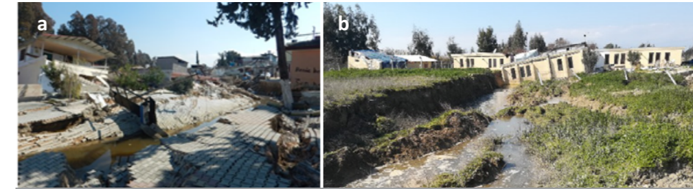
Şekil 7. Demirköprü Mahallesi'nde sıvılaşma ve Asi Nehri kıyısındaki binaların yanal yayılma sonucuna nehrine doğru hareketi (Ulusay vd., 2023)
