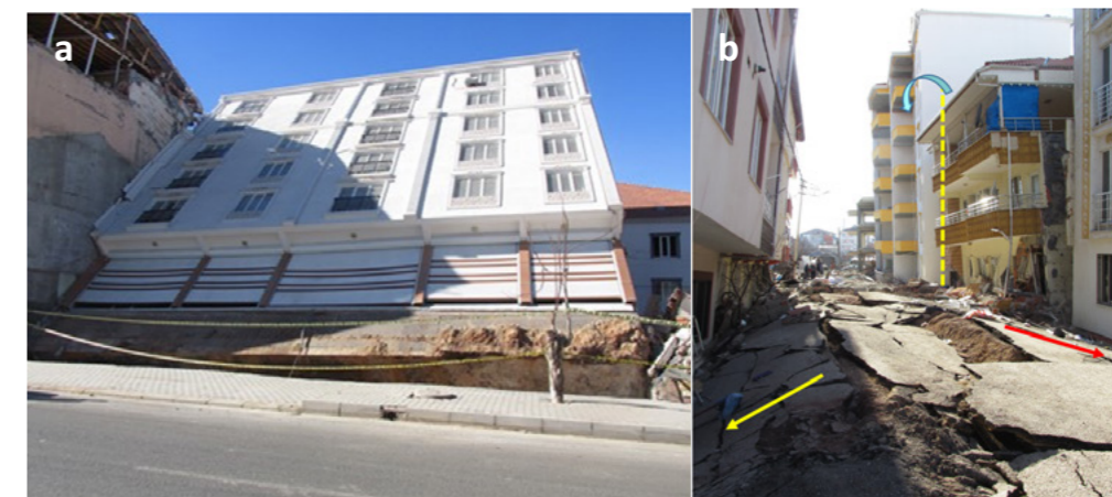
Şekil 8. Gölbasi İlçe merkezinde (a) sıvılaşma ve yüksek yatay ivme sonucu devrilme etkisine maruz kalmış bir bina, (b) sıvılaşma nedeniyle binalarda batma/oturma ve eğilmelerden örnekler
