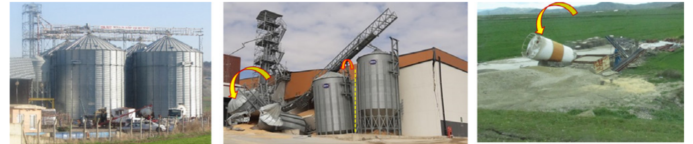
Şekil 17. Deprem bölgesinde (a) hasarsız ve (b-c) hasarlı silolardan seçilmiş görüntüler (Ulusay vd., 2023)
