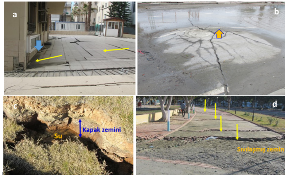
Şekil 5. İskenderun Atatürk Bulvarı'nda (a) Sıvılaşma sonucunda binaların ve yer kaplamalarının zemine batması, (b) gömülü yapıların sıvılaşmaya bağlı yükselmesi (c) yarıktaki su ve kapak zemininin görünümü ve (d) yanal yayılma yarığını doldurmuş sıvılaşmış zemin
