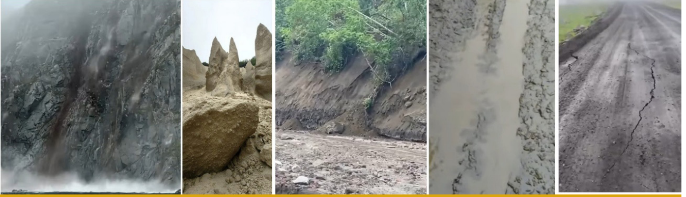
Şekil 15. Deprem bölgesinde gözlenen jeoteknik hasarlar (değişik internet kaynaklarından)
