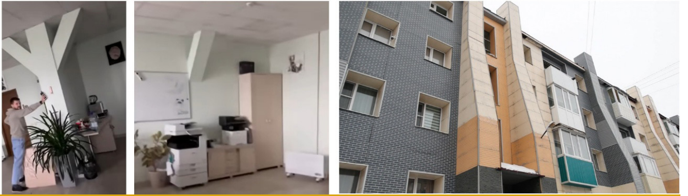
Şekil 13. Yapıların depreme karşı güçlendirilme uygulamaları (değişik internet kaynaklarından)
